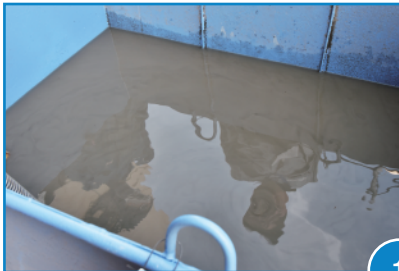
脱水前の汚泥水
