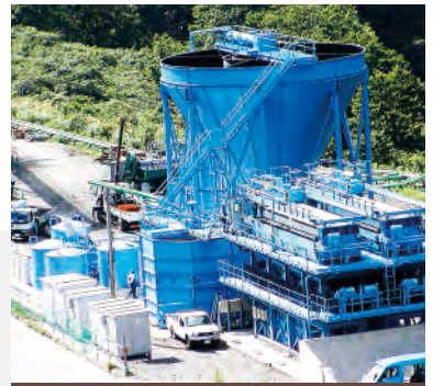
大型濁水処理設備
